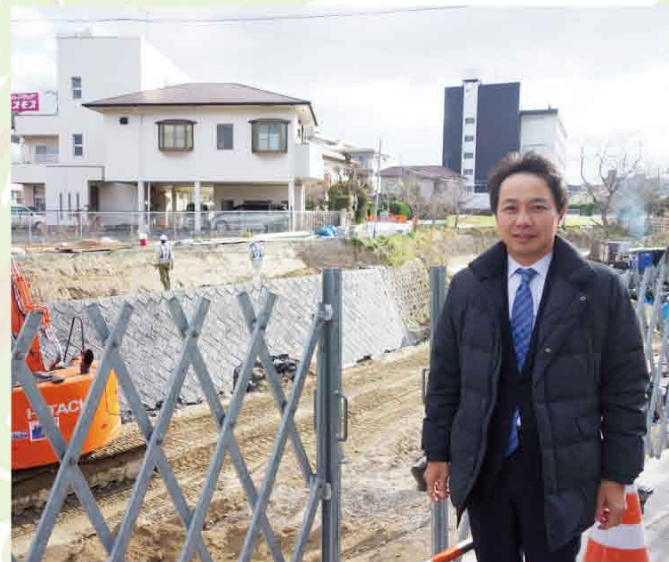
樋井川の護岸崩壊の現場工事に立会う
