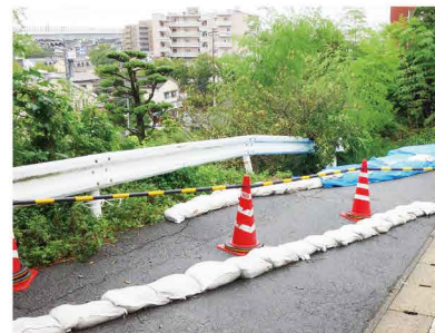
大雨による土砂災害が発生しました
