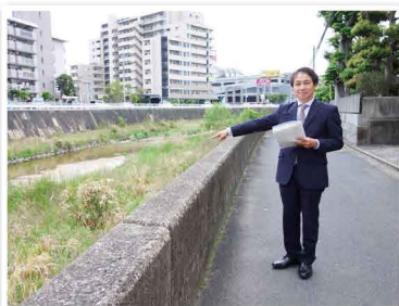
樋井川の河川状況を視察しました
